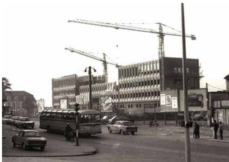
Le nouvel Hôtel de Ville en construction
